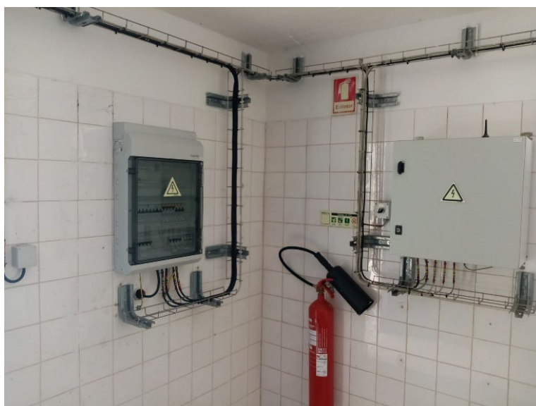
Imagem 45: Quadro elétrico após intervenção
