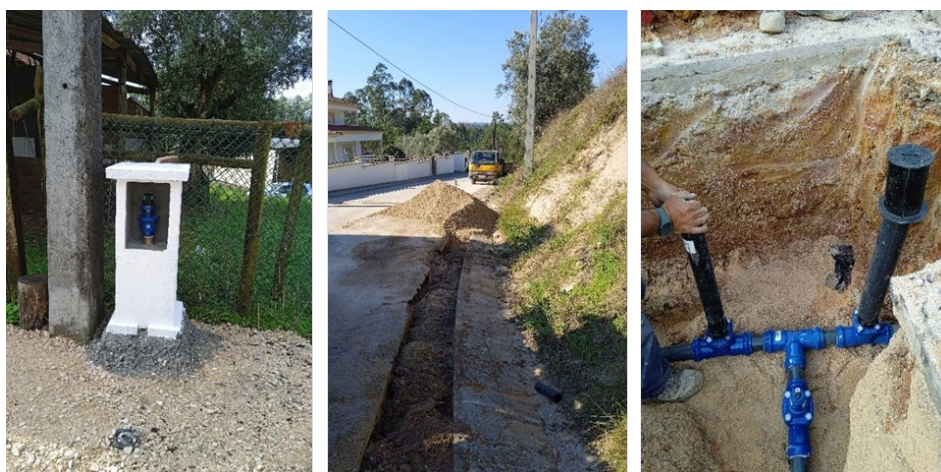
Imagem 39: Abertura de vala no âmbito da ampliação
