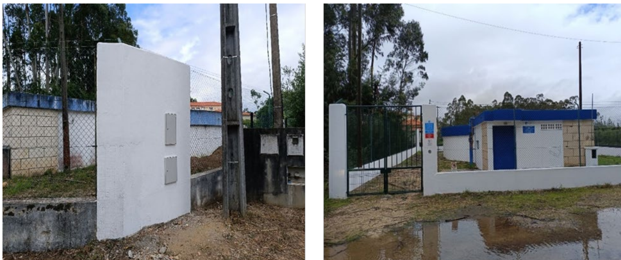
Imagem 44: Murete técnico para instalação do contador de energia (esq.) e aspeto geral da instalação após pintura (dir.)
