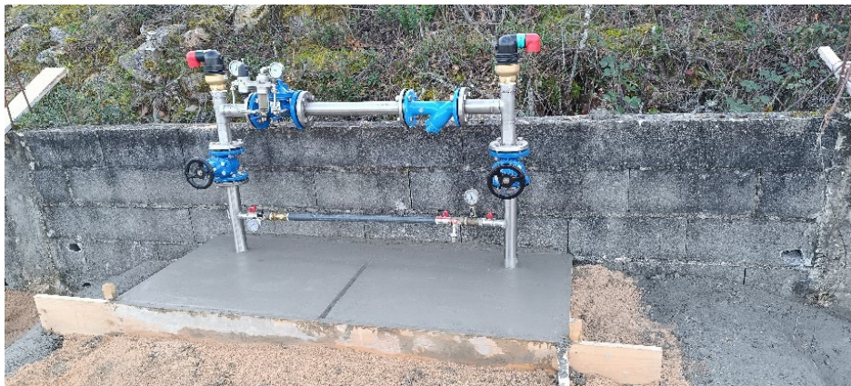
Imagem 48: Desenvolvimento da obra de instalação de VRP
