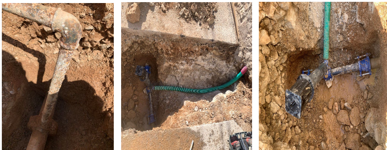
Imagem 33: Renovação de ramal na Rua dos Casanhos, Moita Redonda, Fátima
