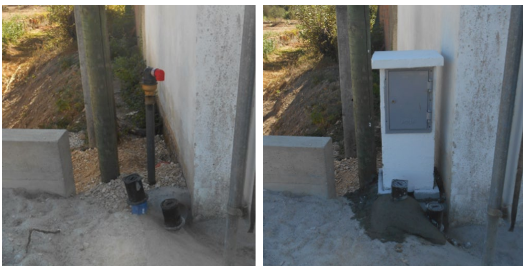
Imagem 36: Ventosa e marco de ventosa renovados
