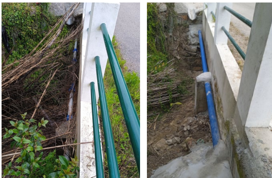
Imagem 38: Reabilitação de tubagem na ponte do Folgado para o Casal da Bica
