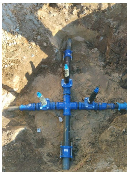
Imagem 35: Substituição/ renovação de válvulas de seccionamento
