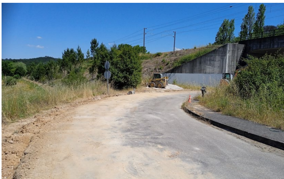
Imagem 40: Empreitada em execução, Rua de São Valentim, Sorieira
