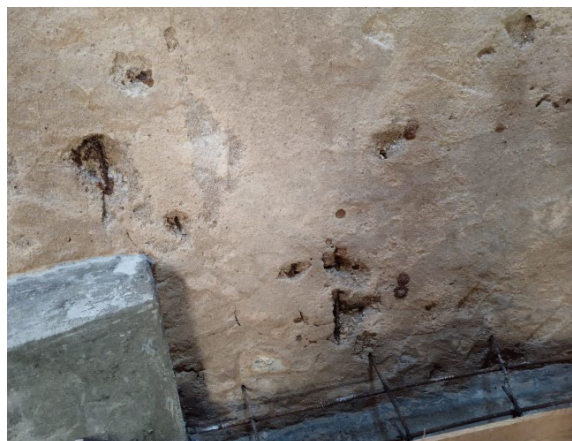
Imagem 42: Patologias verificadas no interior da célula do reservatório
