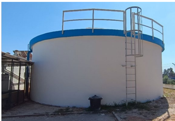
Imagem 43: Reservatório após intervenção
