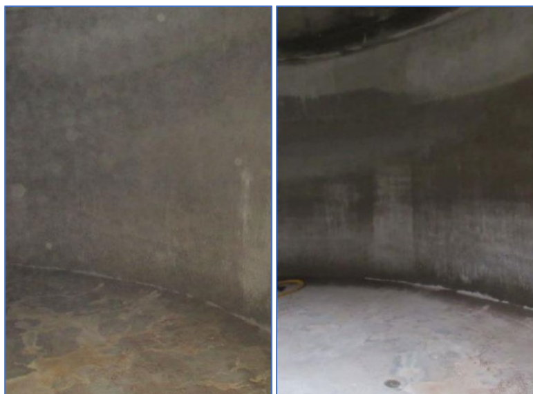
Imagem 32: Higienização de reservatório
