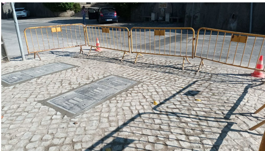
Imagem 49: Desenvolvimento da obra de equipamento de medição e instalação de VRP
